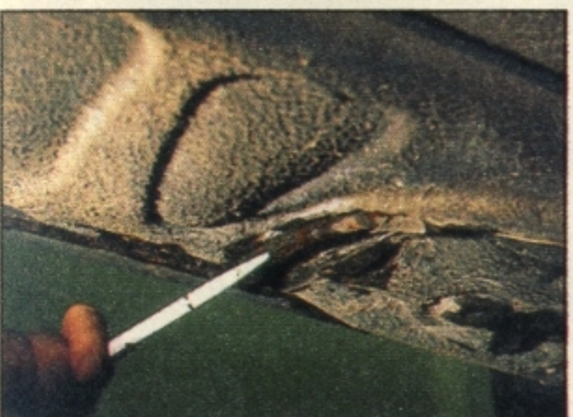
Bodenblech: Hier haben Wagenheber zerstörerisch gewirkt
